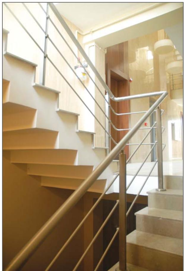
🇫🇷 "art65", notre nouveau système de poteau qui est une version renforcée de "Art45" a été développé pour répondre aux attentes de stabilité les plus élevées. Les poteaux sont composés de deux pièces profilés extrudés de 65x13 mm et en raison de la grande variété de modèles, il est souvent préféré sur les marchés d'Europe occidentale et d'Amérique du Nord.
